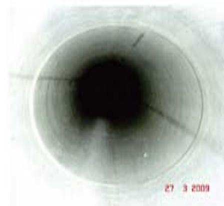
**Bild 7:** Mit dem Gewebeschlauchsystem starline®HPL-S rehabilitierte Rohrleitung DN 500 GG
