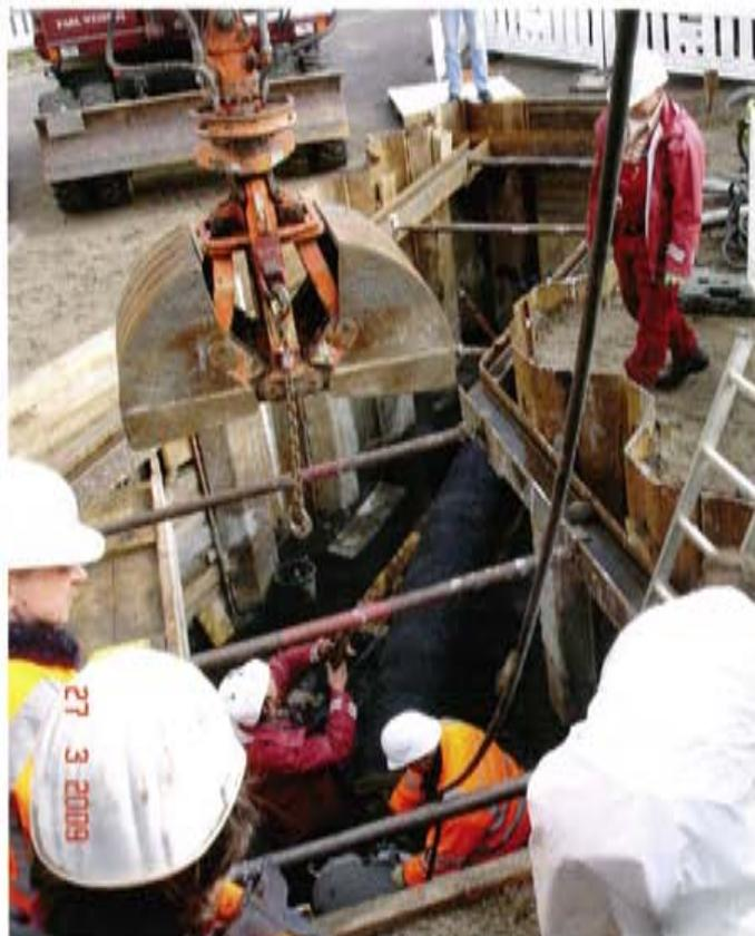
**Bild 4:** Flexible Schleusentechnik ermöglicht den Einsatz auch bei beengten Baugrubenverhältnissen
