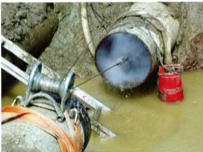
**Bild 1:** Wasser-Höchstdruck-Reinigung
