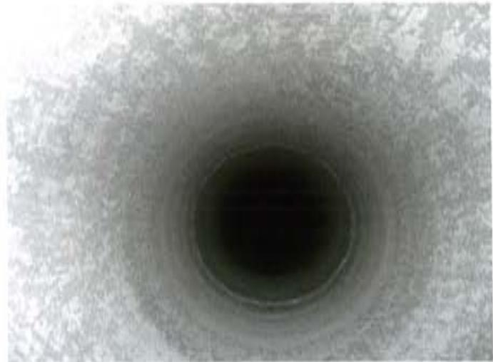
**Bild 2:** Rohrinnenoberfläche der Graugussleitung nach Sandstrahlreinigung
