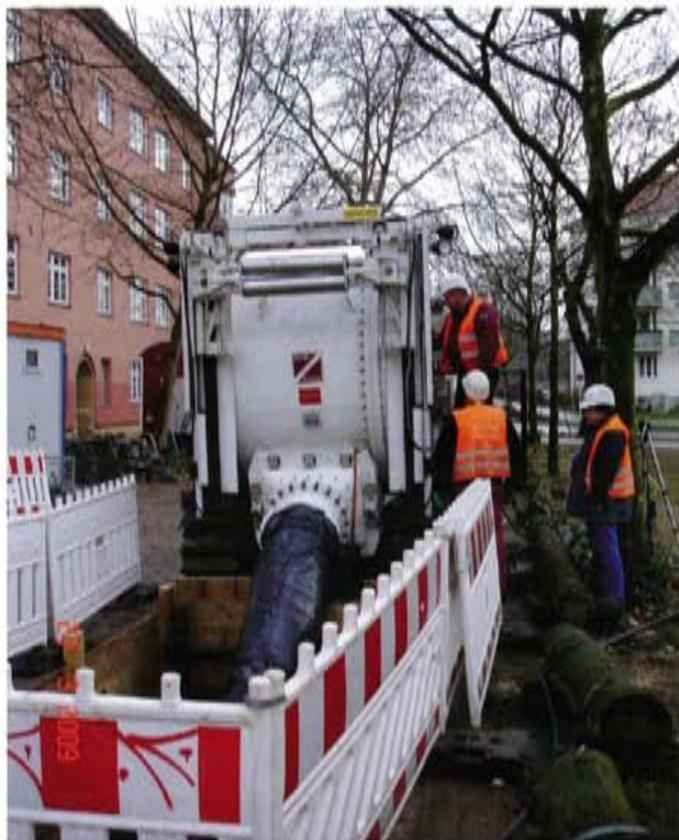
**Bild 3:** HPL-Technik: Drucktrommel DT 600-4.5 für Reversionslängen bis 600 m
