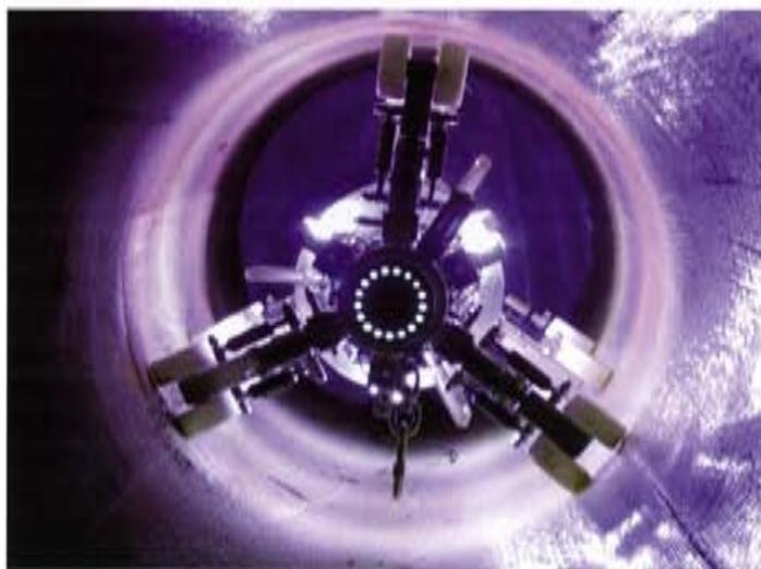
**Bild 5:** Eine Spezial-Strahlungsquelle ermöglicht erstmalig die Schnellaushärtung von Gewebeschläuchen ohne thermische Beeinträchtigungen
